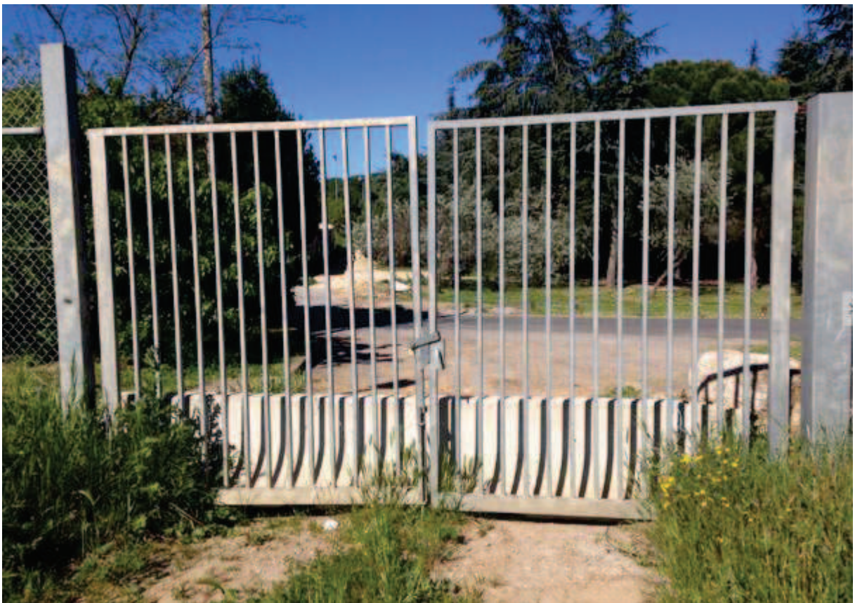
Zone vue Ouest : Sécurisation du site
