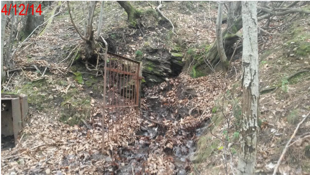
Illustration 3 – Entrée partiellement obstruée d'une ancienne galerie minière (Camplong)
