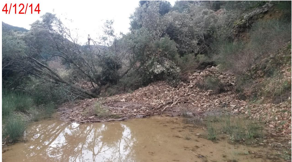
Illustration 2 – Coulée de boue ayant barré deux chemins du Réseau vert et une piste DFCI (Camplong)
