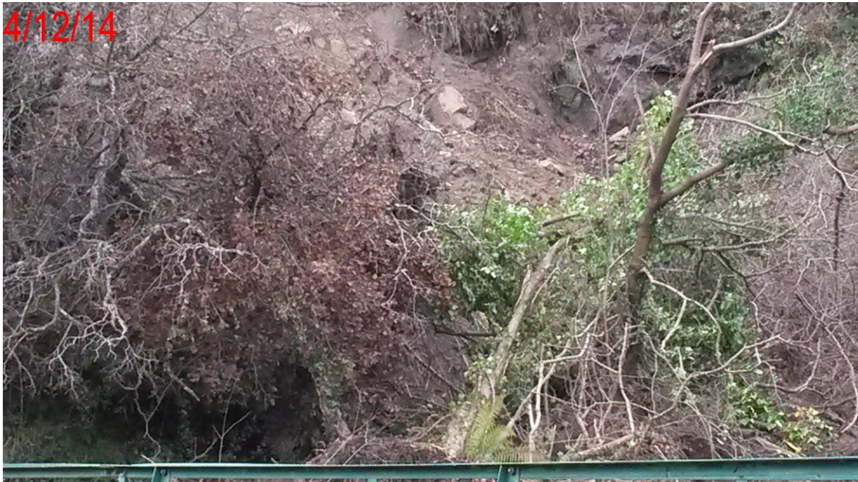
Illustration 5 – Glissement rive droite du Clédou lors de sa traversée du bourg (Graissessac)
