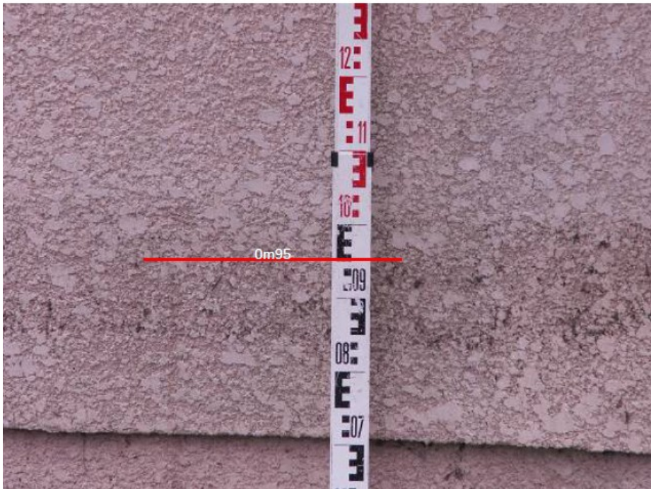
Illustration 17: Relevé des laisses de la crue – Rue de Caubel
