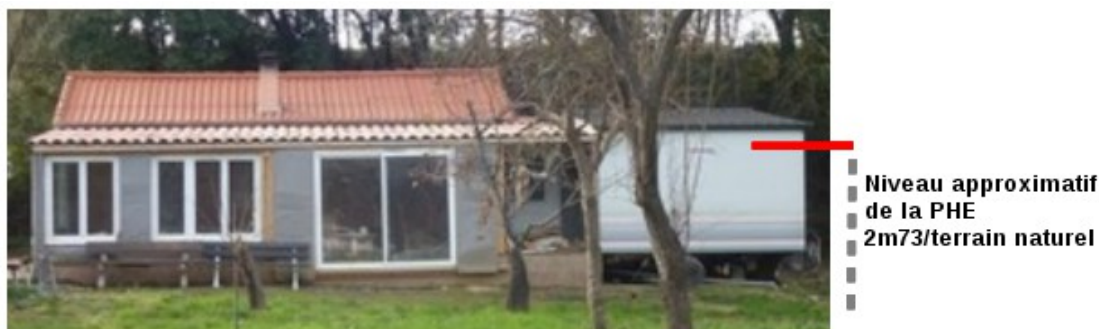
Illustration 25: Hauteur d'eau à l'extérieur de la maison le 29 septembre 2014
