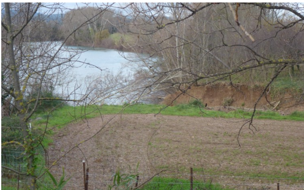
Illustration 5 : Confluence Rouviège / Hérault - érosion des berges du Rouviège Photo prise depuis les habitations (Source : auteurs)
