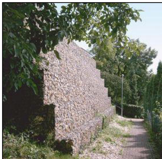
Mur réalisé à l'aide de gabions
