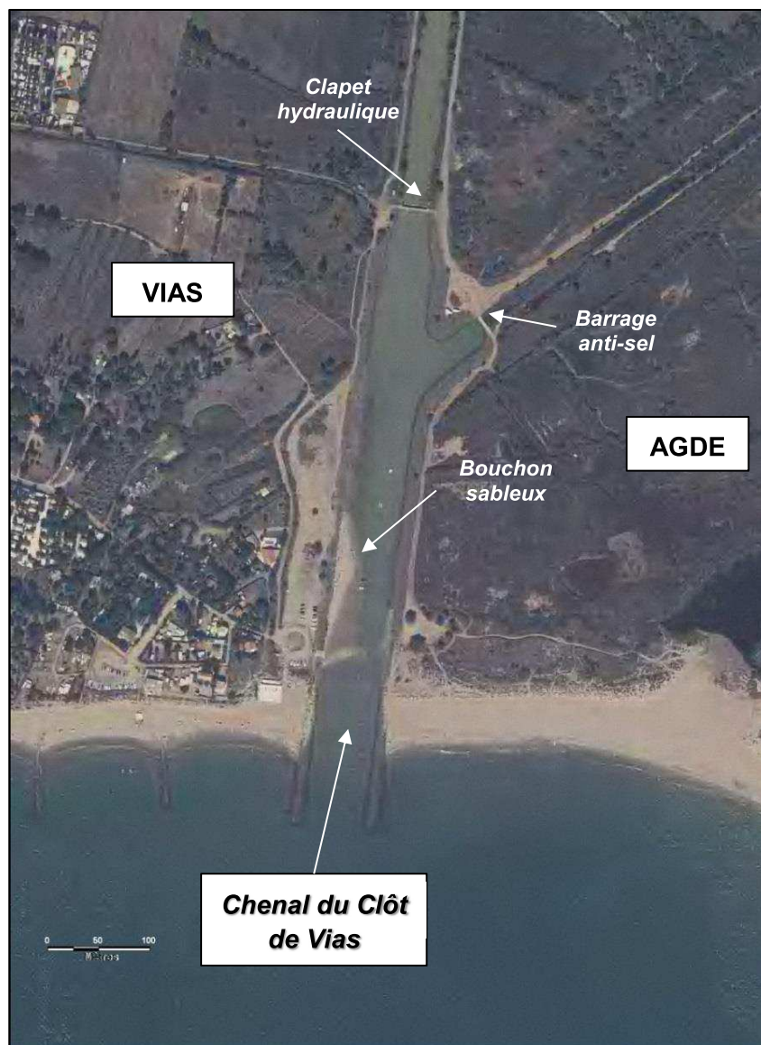
Figure 3 : Présentation des caractéristiques du chenal du Clôt du Vias (Artelia, 2013)
