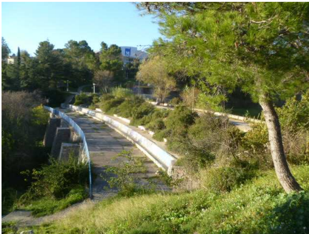
Figure 2 : Vue du barrage depuis la rive gauche
