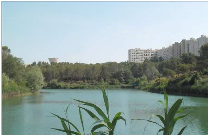
Figure 1 : Vue de la retenue depuis le barrage
