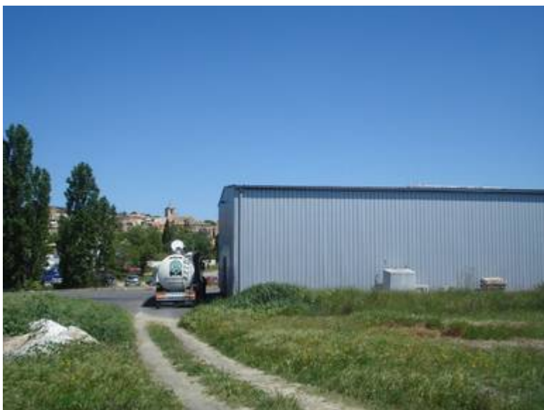
2- Chai côté Sud
