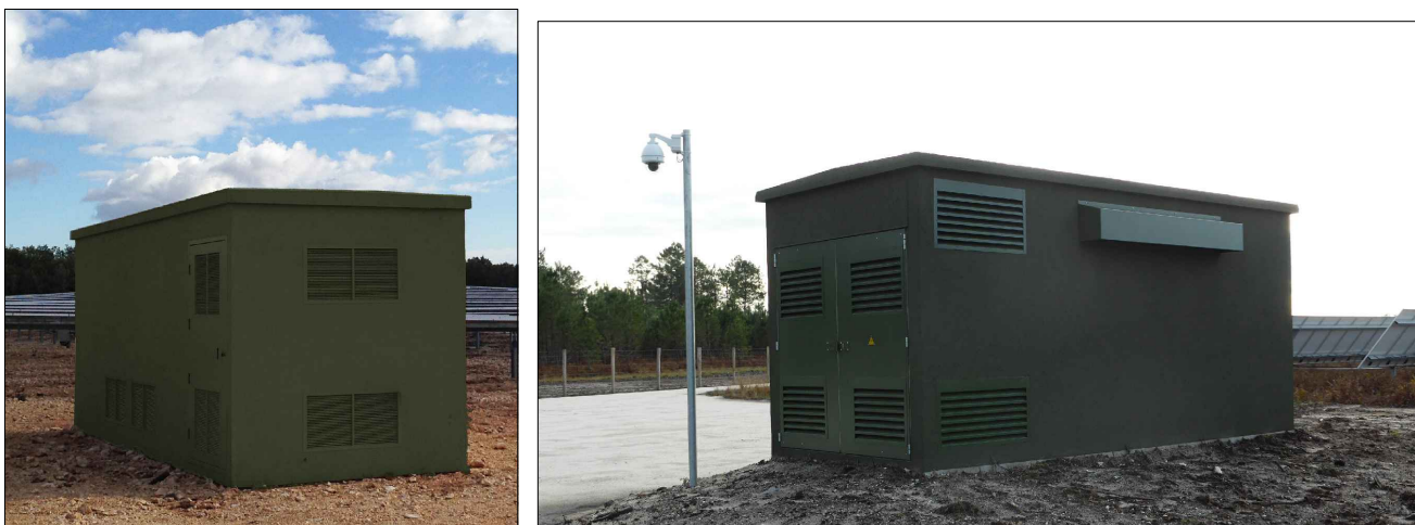
LOCAUX POUR ONDULEURS ET TRANSFORMATEURS
