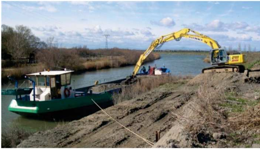
Figure 21 : Exemple d'opérations de reprise des sédiments le long du canal du Rhône à Sète (VNF)
