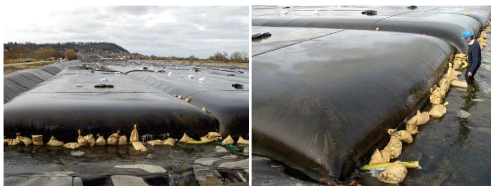
Figure 15 : Exemples de géoconteneurs filtrants en cours de remplissage (Tencate)
