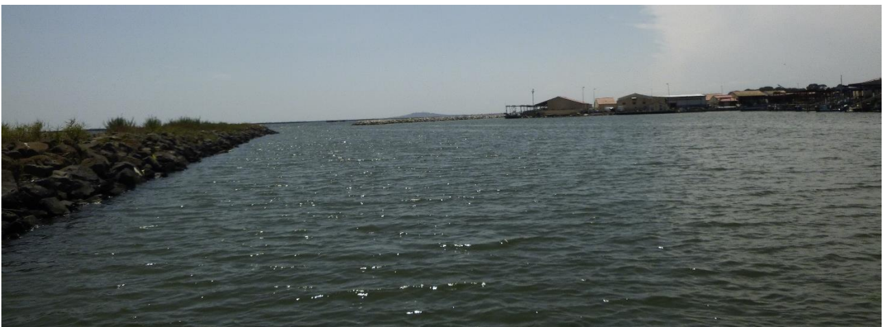
Figure 35 : Photographie de la passe d'entrée sud du port du Mourre Blanc
