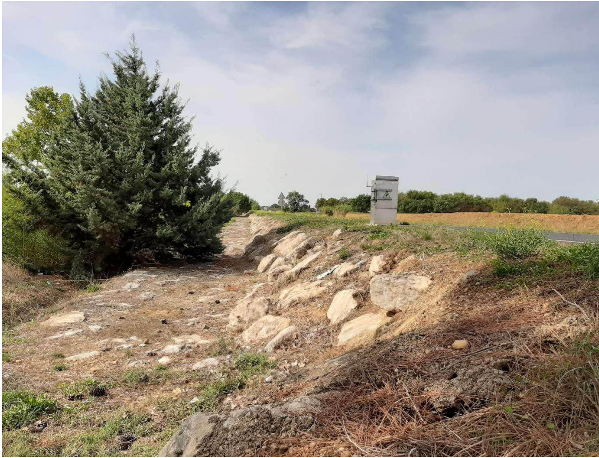
1 Vue de la digue côté Est
