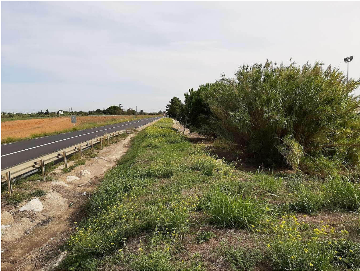
2. Vue de la digue côté Ouest
