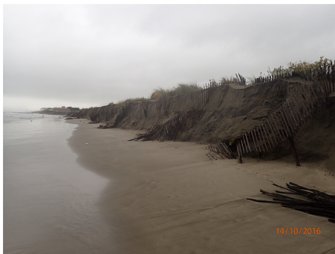
Secteur du Petit-Travers – Carnon 14/10/2016 - Photo DDTM 34
