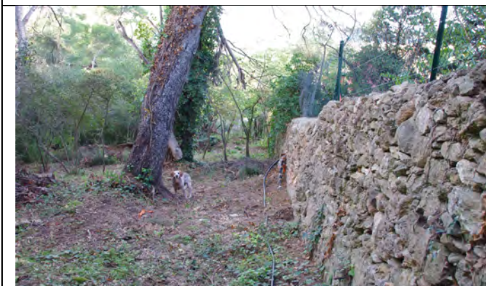
Mur de clôture en pierres
