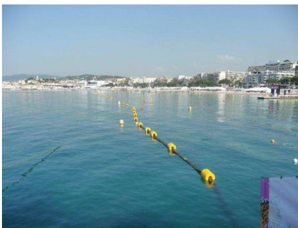
Fig. 79. Photographie de la conduite flottante
