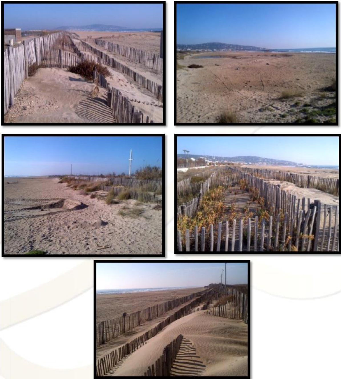
Fig. 54. Photographies du Lido lors des investigations du bureau d'étude Luxmarina
