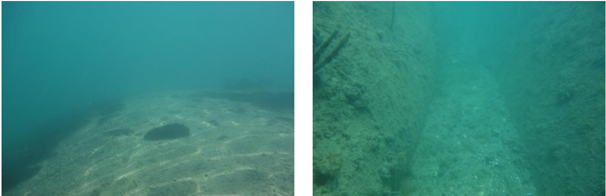
Fig. 55. Photographies sous-marine de l'ouvrage immergé existant
