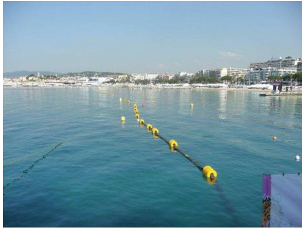
Fig. 8. Photographie de la conduite flottante
