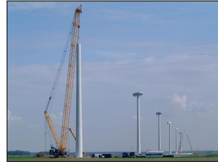
Photographie 25 : Un parc de neuf éoliennes Vestas V80 en construction
