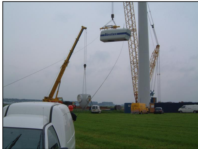
Photographie 24 : Montage de la nacelle
