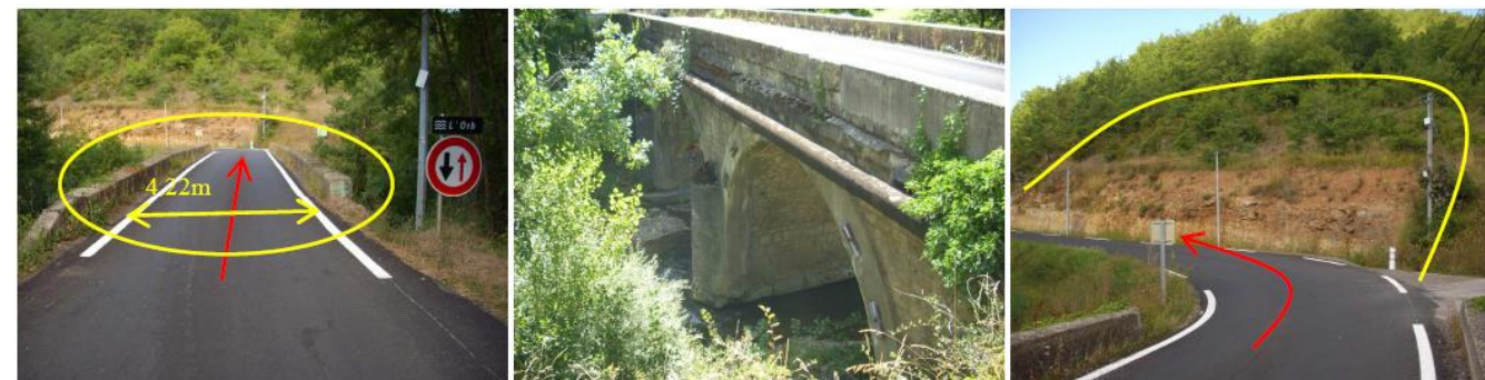
Photographie 9: Le pont de franchissement de l'Orb au niveau du lieu-dit Le Mas Neuf.
