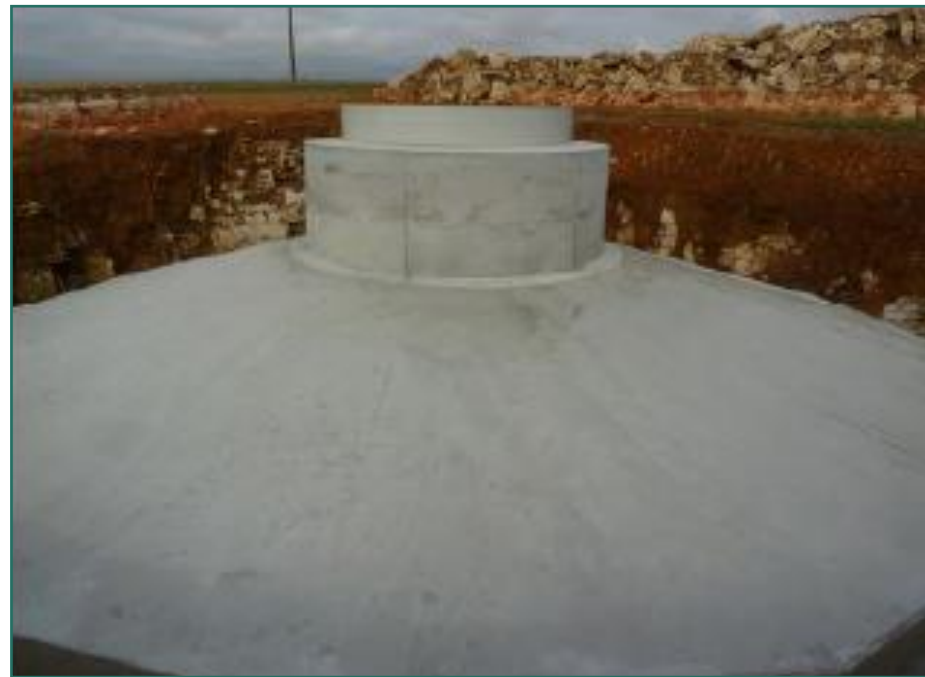
Photographie 18: Fondation après coulage béton
