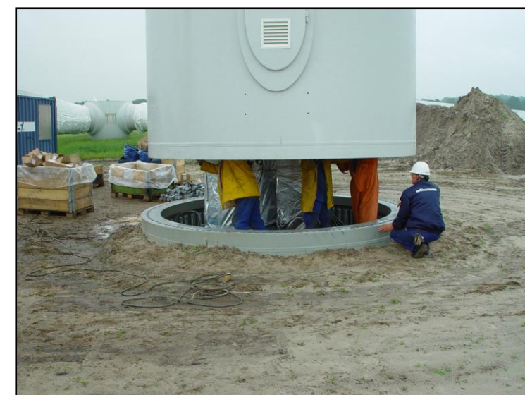
Photographie 22 : Montage du mât sur la fondation
