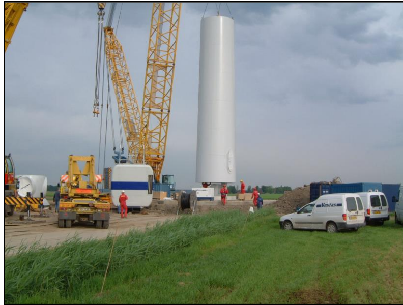
Photographie 23 : Montage de la première section du mât
