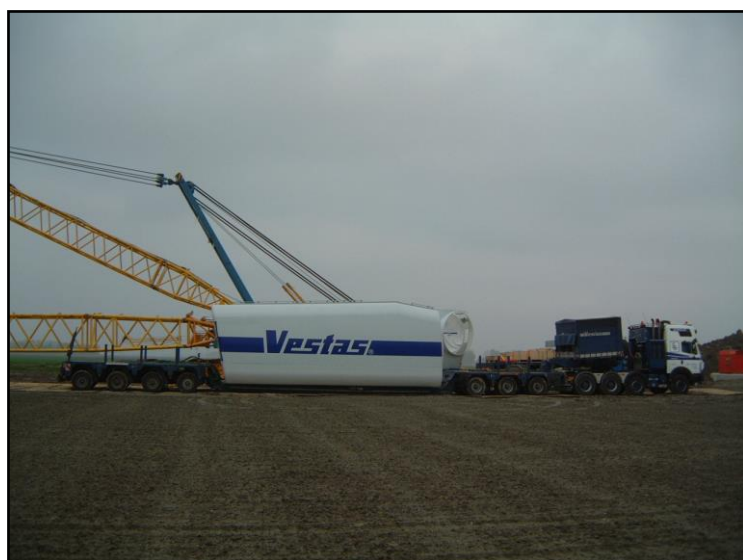
Photographie 20 : Transport de la nacelle
