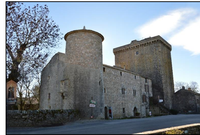
MH n°13 - Tour de Viala du Pas de Jaux
