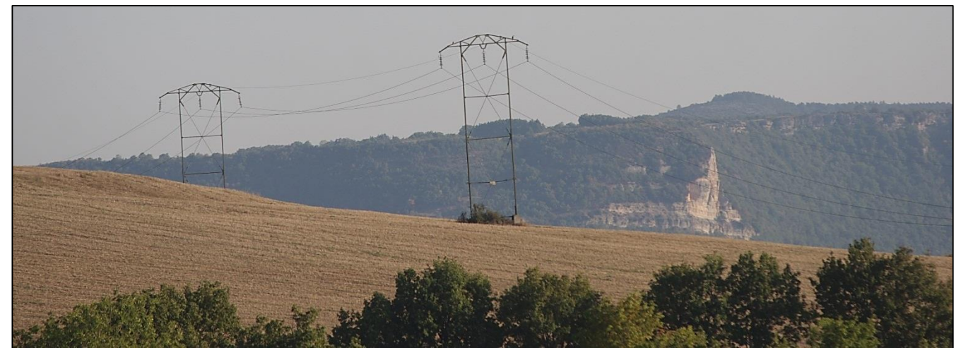
figure n° 1. Cliché de la ligne haute tension au nord du périmètre rapprochée de l'aire d'étude
