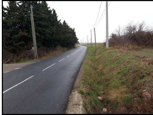
Vue du cours d'eau du BV1e bordant la RD28
