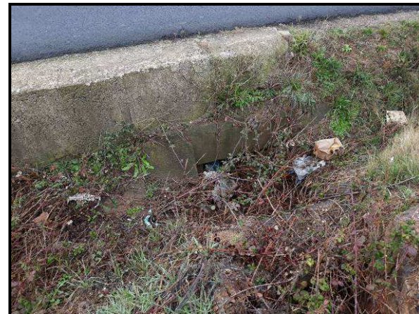
Vue amont l'ouvrage de rétablissement
