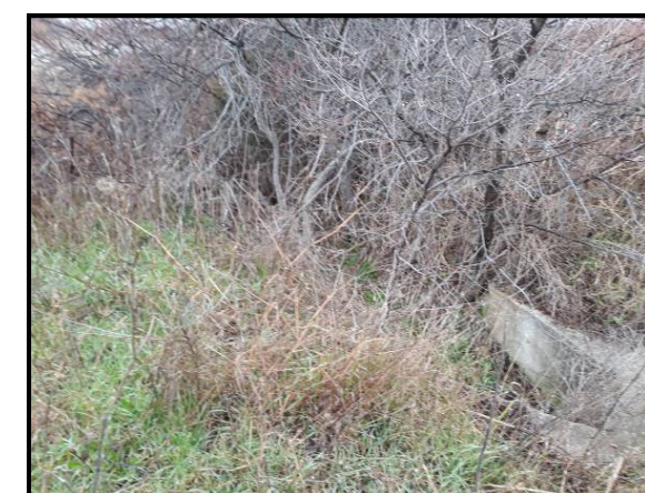
Vue du fossé du BV1d
