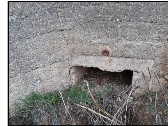
Vue aval l'ouvrage de rétablissement
