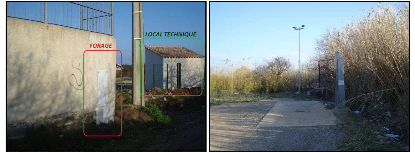
Photos du forage et du local technique ainsi que de l'aire de lavage
