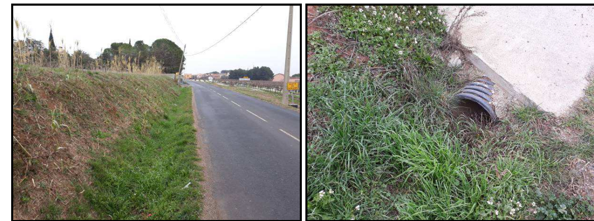
Vues des fossés et ouvrages sur les BV1a à 1c
