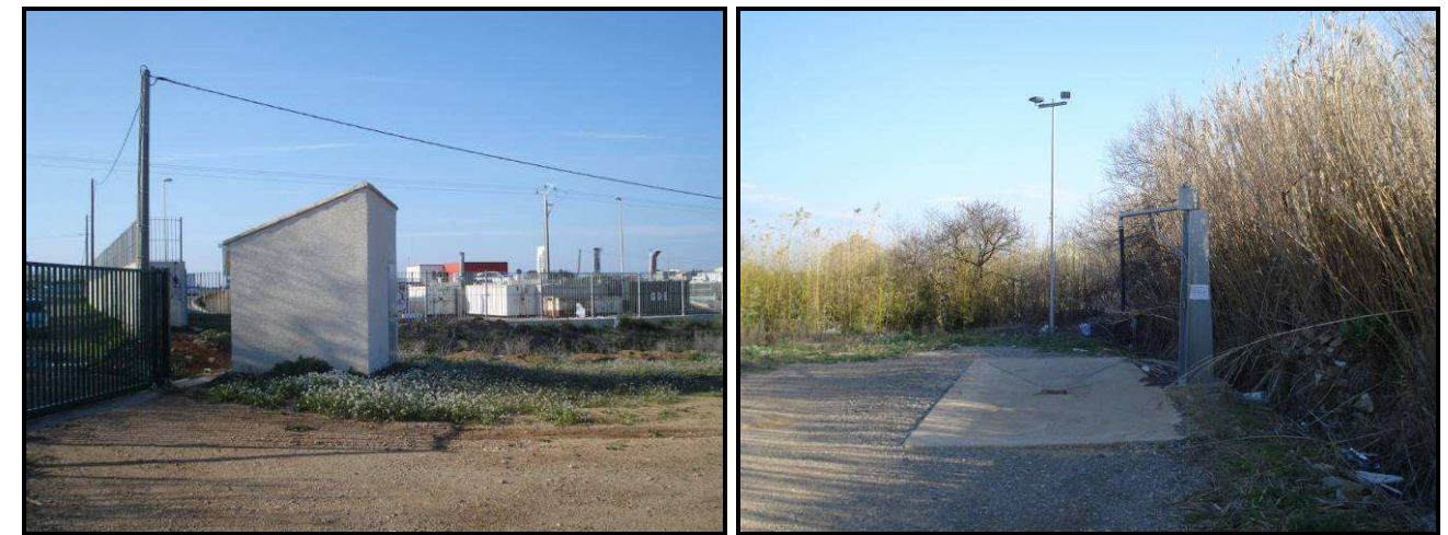
Vues du forage et de l'aire de lavage actuelle
