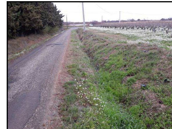
Vue du fossé du BV1 longeant le CR de la Prade
