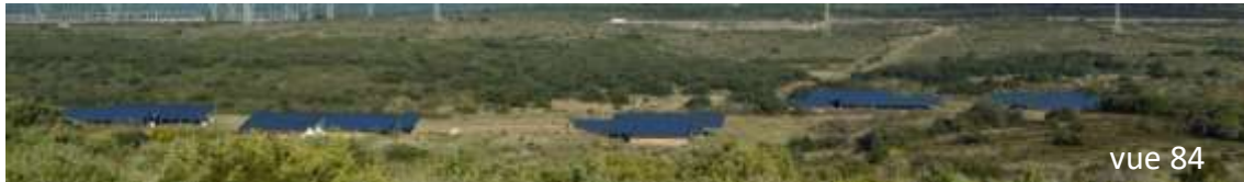
Bâtiments solaires du Mas Dieu
