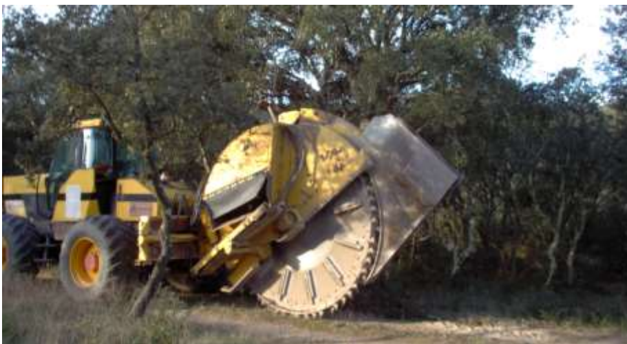
Travaux de raccordement – Trancheuse
