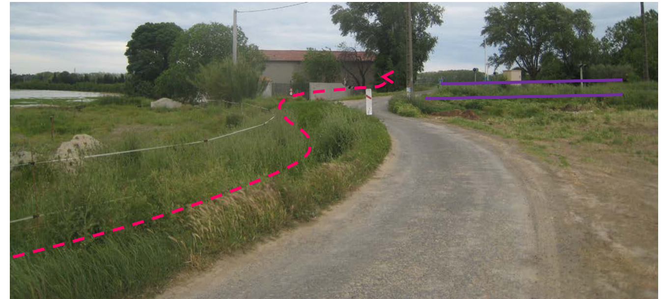
Photographie 9 : Carrefour entre la voie ferrée et le chemin de Gaillague
