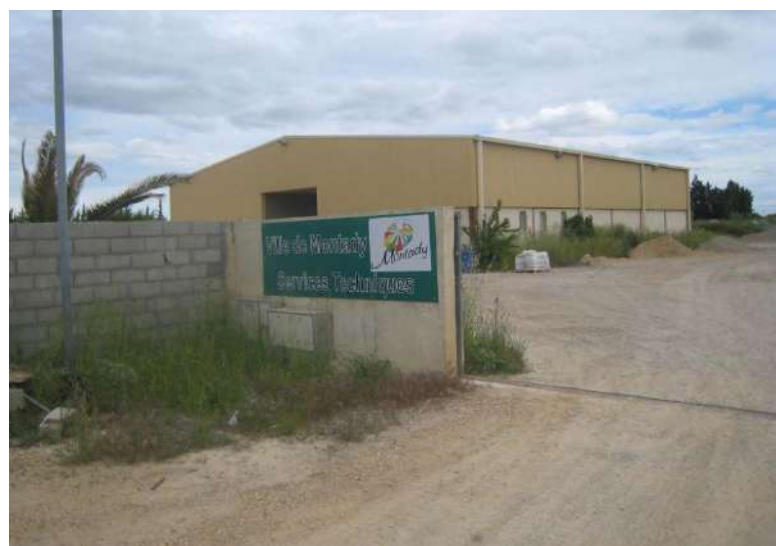
Photographie 35 : Services techniques de Montady sur le site de projet
