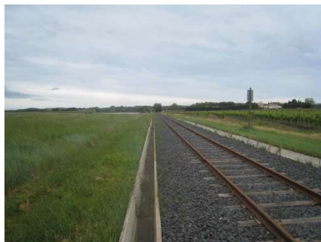
Photographie 11 : Caniveaux le long de la voie ferrée
