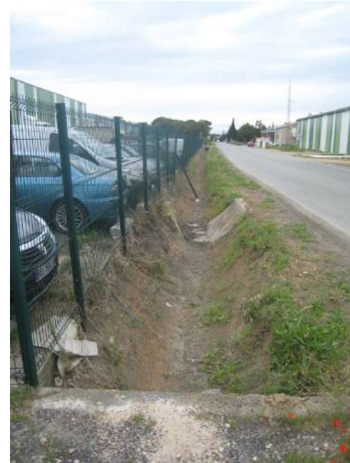
Photographie 6 : Fossé le long de l'avenue de l'Europe – Vue vers l'Ouest
