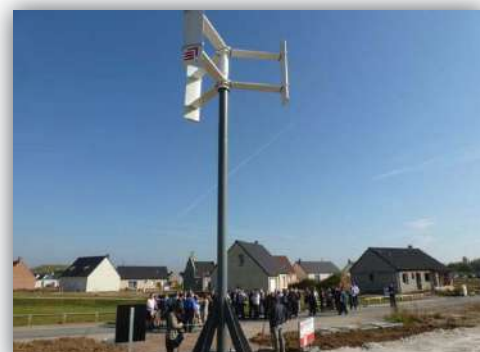
Éolienne à axe vertical, écoquartier de la Marlière (Courcelle-lès-Lens)
