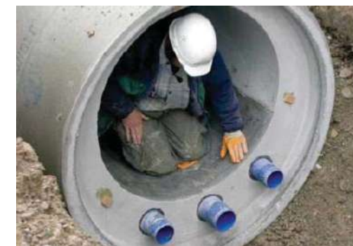
Figure 18 : Canalisation préfabriquée avec échangeur de chaleur intégré (Source : Guide pour les maîtres d'ouvrages et les communes, OFEN)
