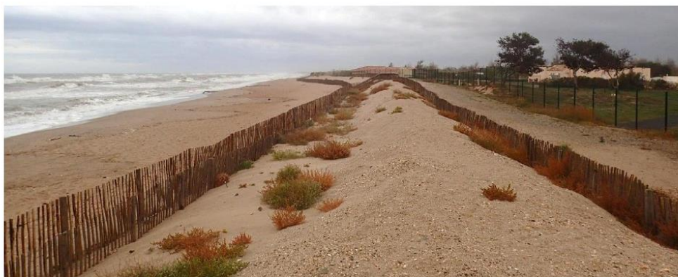
Figure 102 : photographie du 20 octobre 2020 montrant la partie rénovée du cordon (visible comme un cordon de couleur blanche sur l'ortho-image satellite de 2020 en Figure 89)
