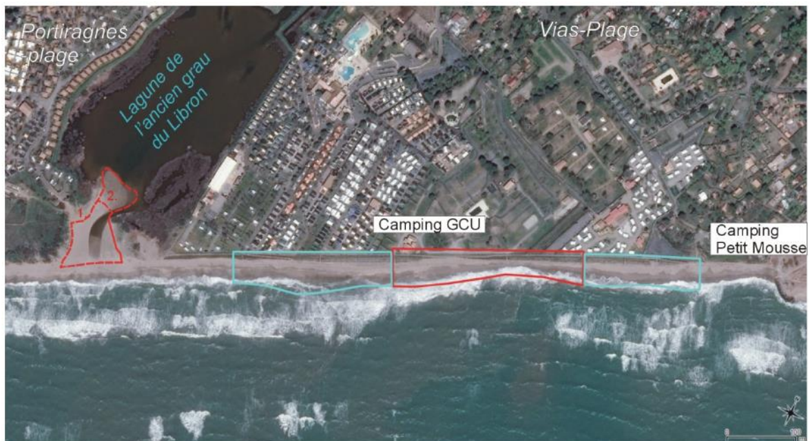
Fig. 2. Zones des travaux, source EID
