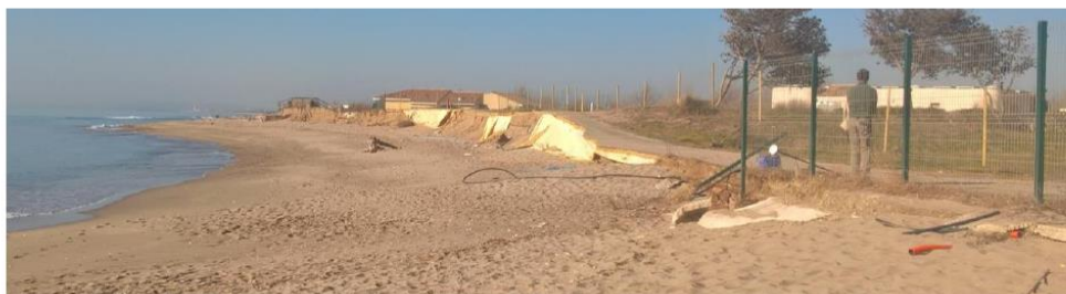
Figure 100 : photo prise de la portion centrale-ouest du cordon de Vias dans l'encoche de très forte érosion le 27 février 2019 © photo EID-Méditerranée
