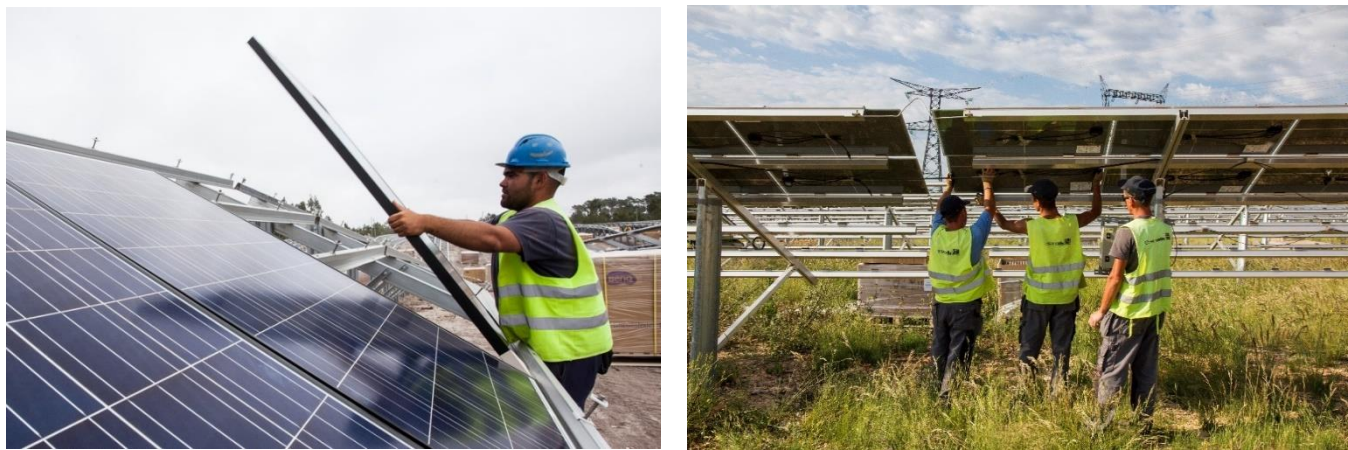
Pose des modules
