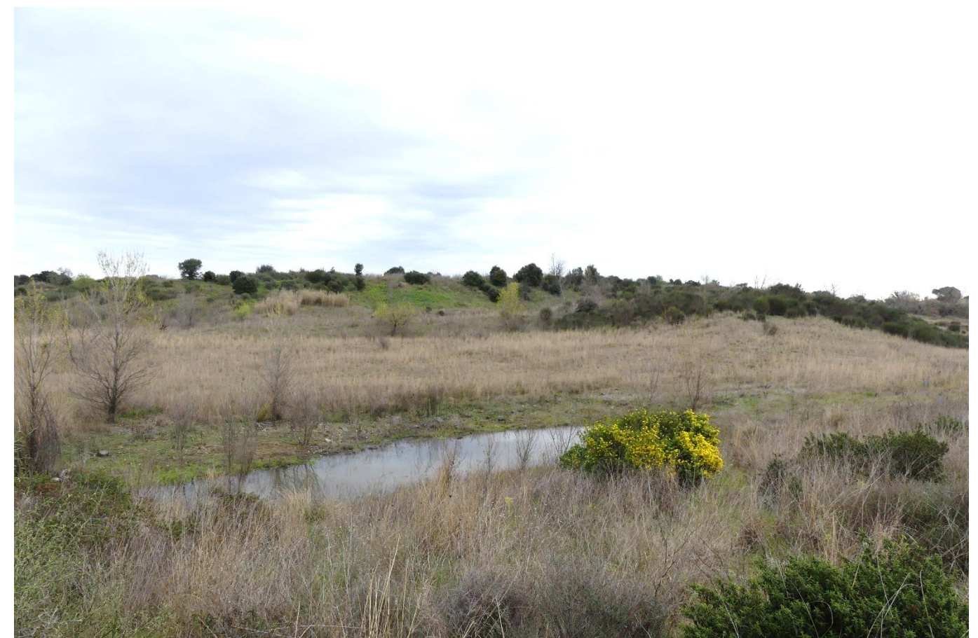
Vue de la carrière accueillant le projet
