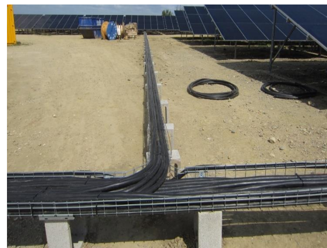
Exemple de chemins de câble hors sol
