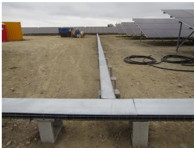
Exemple de chemins de câble hors sol
