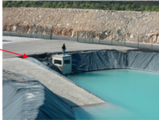
Bassin sud : 3 600 m 3
