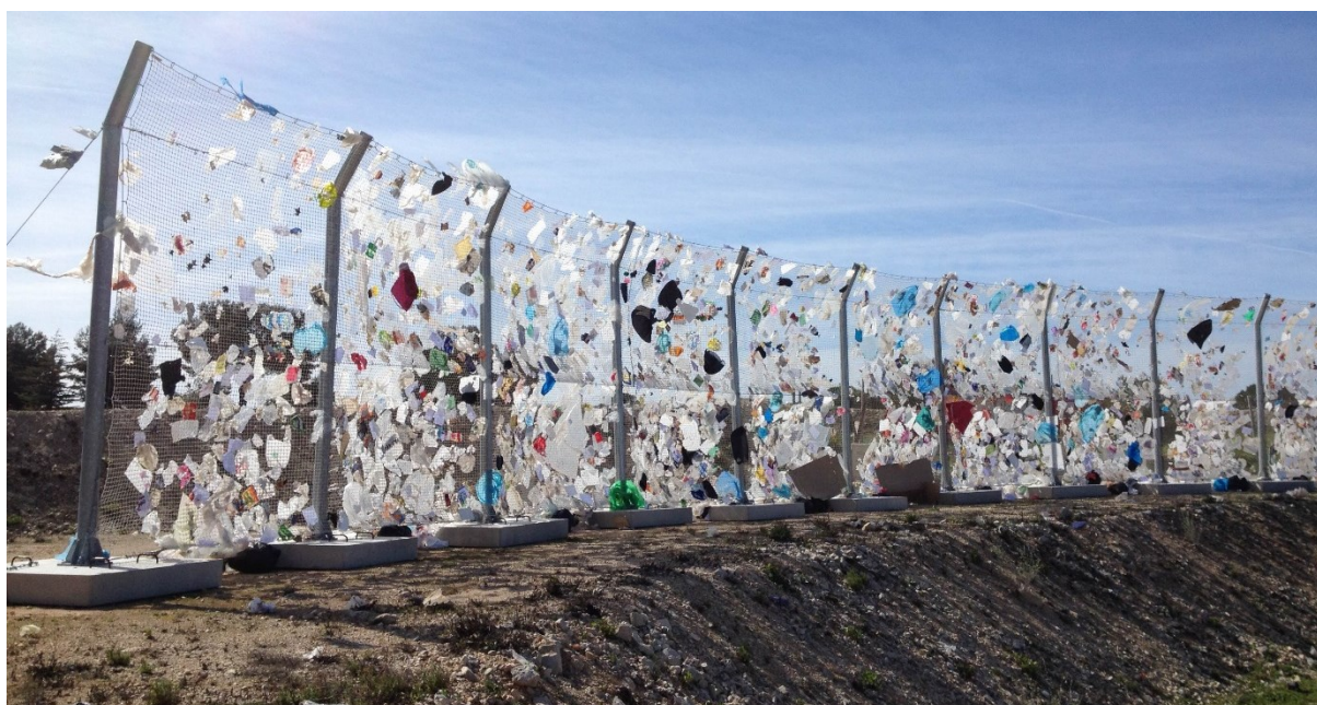
Illustration 24 : Pose de filets garnis autour du casier en exploitation
