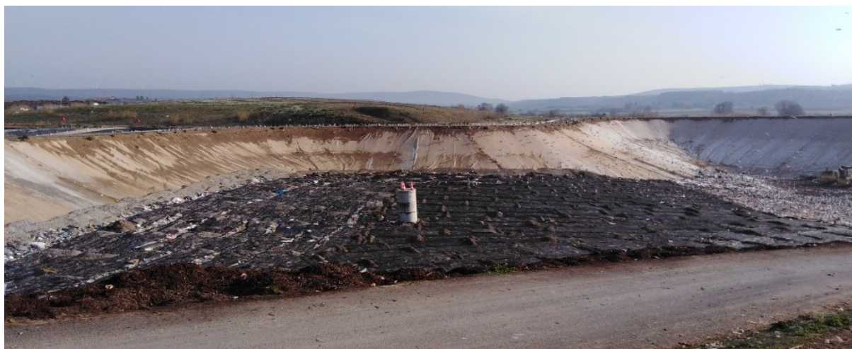
Illustration 23 : Pose de filets perdus en fond de casier Sud
