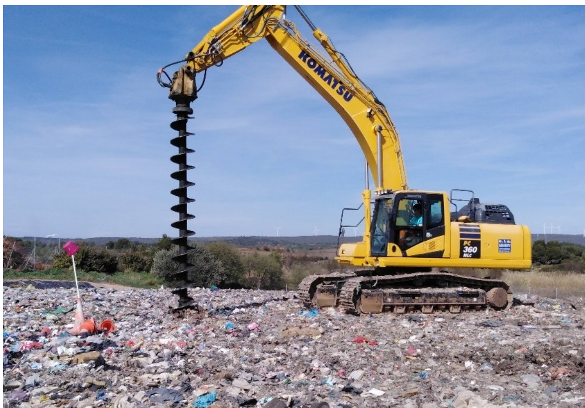
Illustration 20 : Photographie de la foration d'un puits biogaz des casiers Nord
