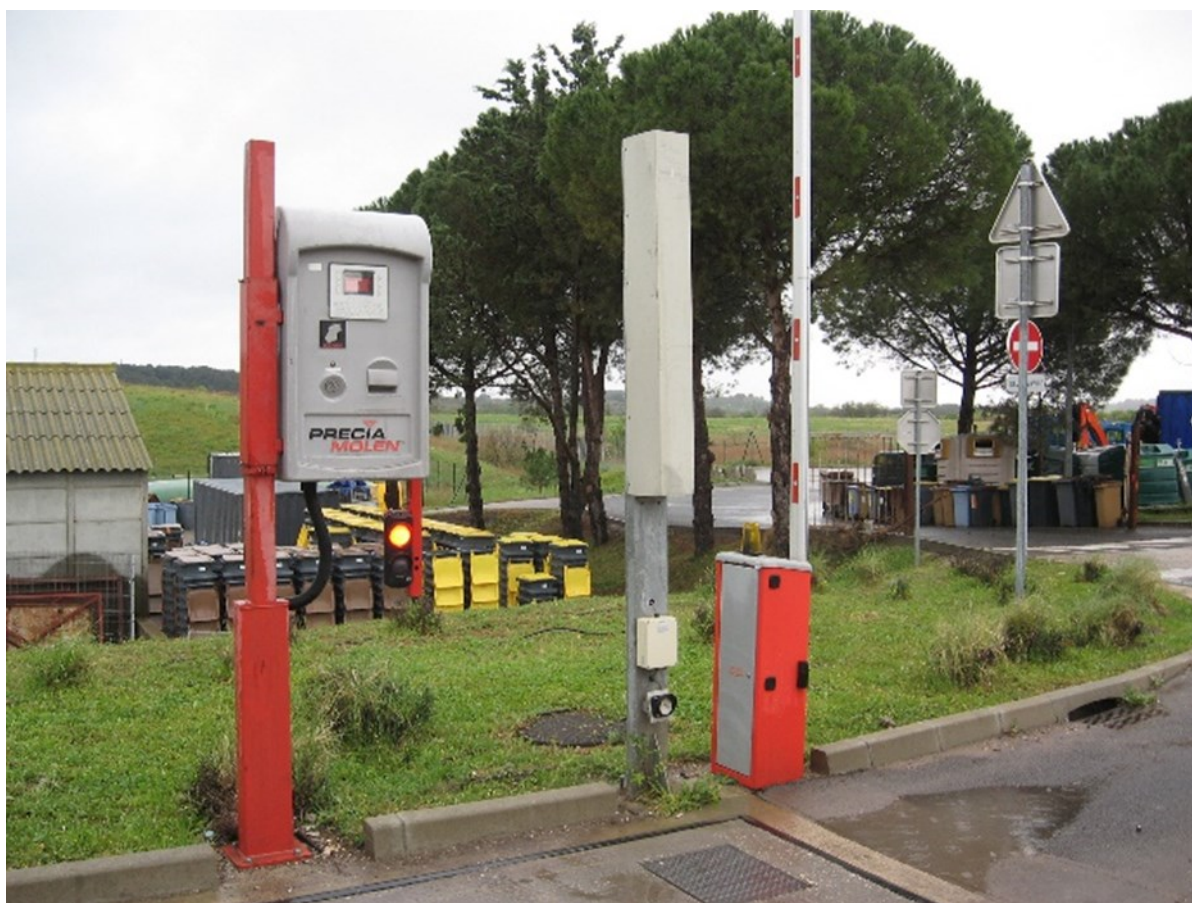
Illustration 29 : photographie du système de détection de la radioactivité
