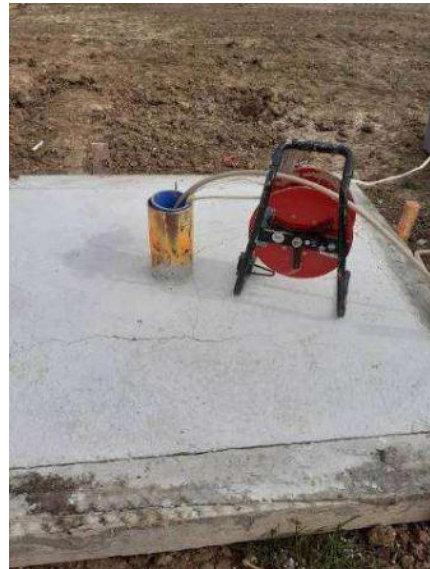
Piézomètre SC1 (position aval)
