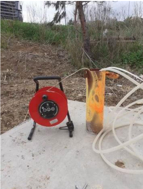
Piézomètre SC6 (position latéral)
