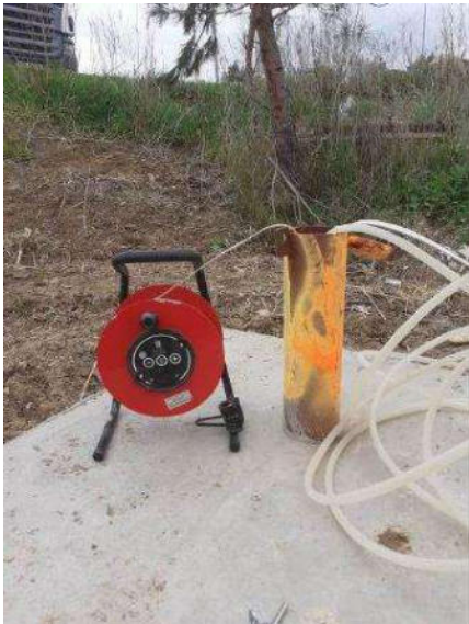
Piézomètre SC6 (position latéral)
