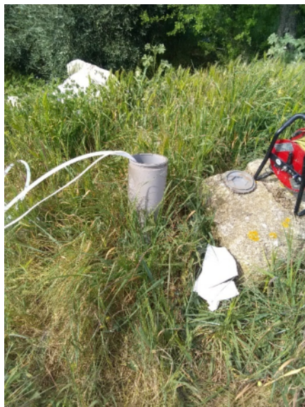
Piezomètre PZ1 (position amont)
