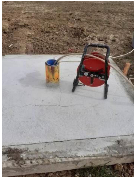
Piézomètre SC1 (position aval)
